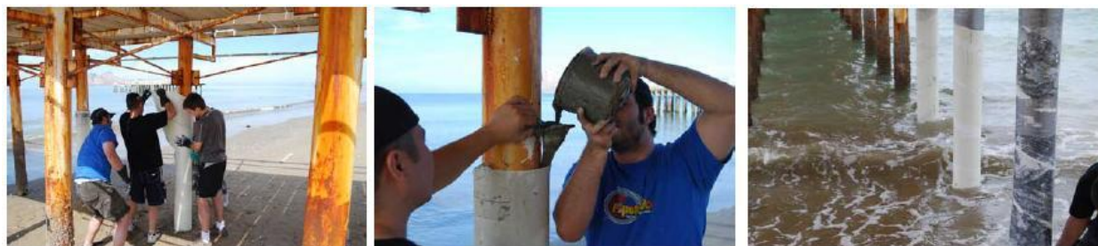
تصویر شماره 7: ساخت یک روکش یکسره ( pileMedic ) در اطراف یک لوله فولادی موجود با سوپرلمینیت ؛ پرکردن فضای حلقوی با دوغاب و چشم اندازی از شمع های بهسازی شده
